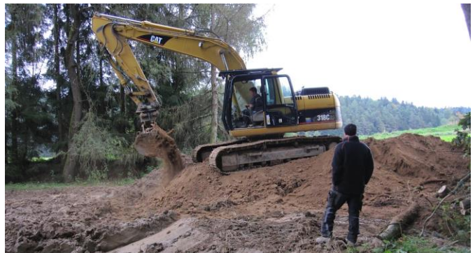
Neue Teiche für die Laubfrösche. Der Bagger der Fa. Stowasser schafft neuen Lebensraum
